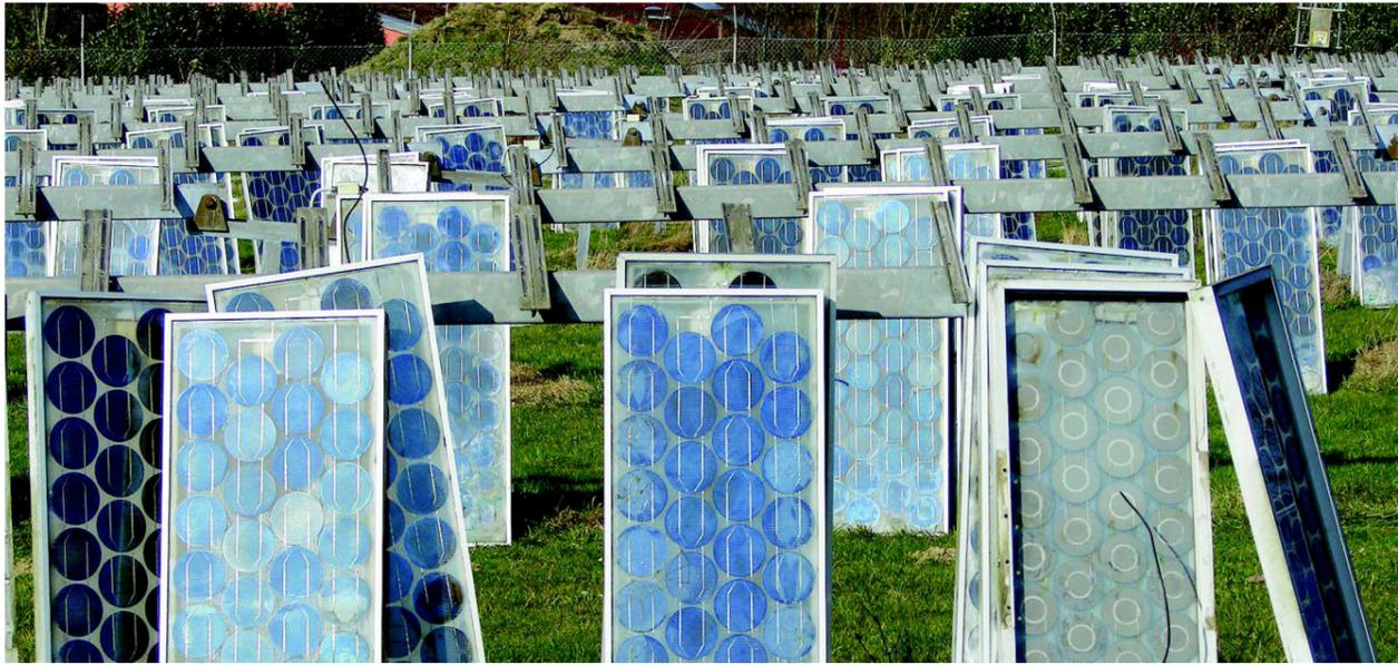
PHOTO 89 : PANNEAUX PHOTOVOLTAÏQUES EN FIN DE VIE
